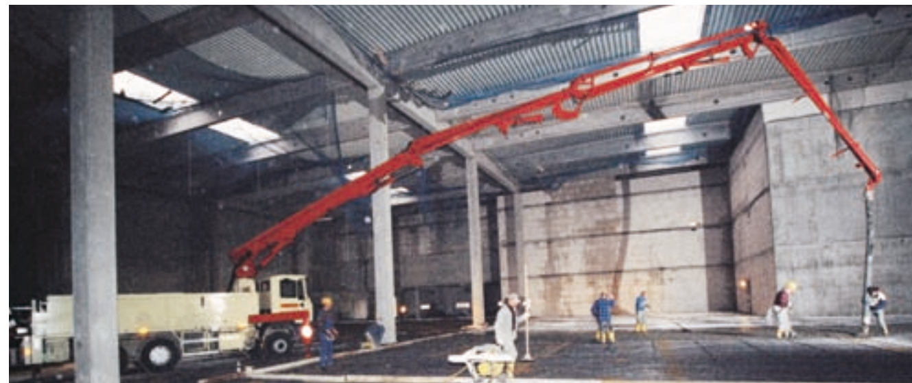
Ideal para el hormigonado en naves: sólo 6,50 m de altura de desplegado.
