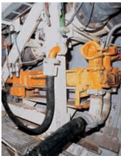
Eine KOV 1050 pumpt den Injektionsmörtel hinter die Tübbinge
