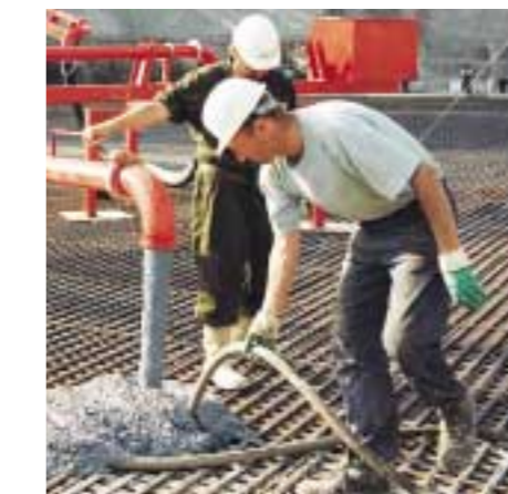
Distribuidor mecánico RV 10 para una colocación sencilla del hormigón.
