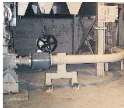
Bombeo de lodos de clarificación en una central eléctrica a través de tuberías 2 x 200 IP.
