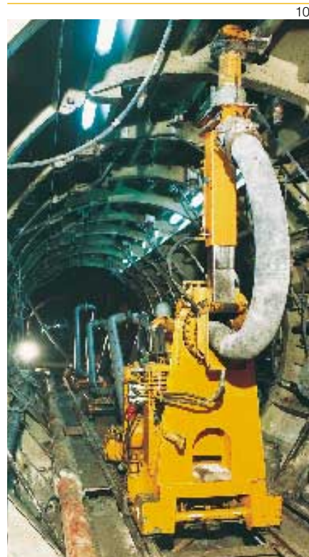
Hormigonado de túneles con tuberías flexibles SK.
