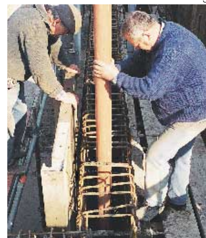
Reducción para tubo de plástico. Adecuado para encofrados estrechos.
