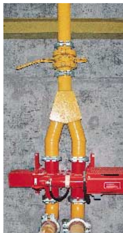
Distribuidor de lechada. Tuberías 2 x 150 IP en una planta de combustión de residuos.
