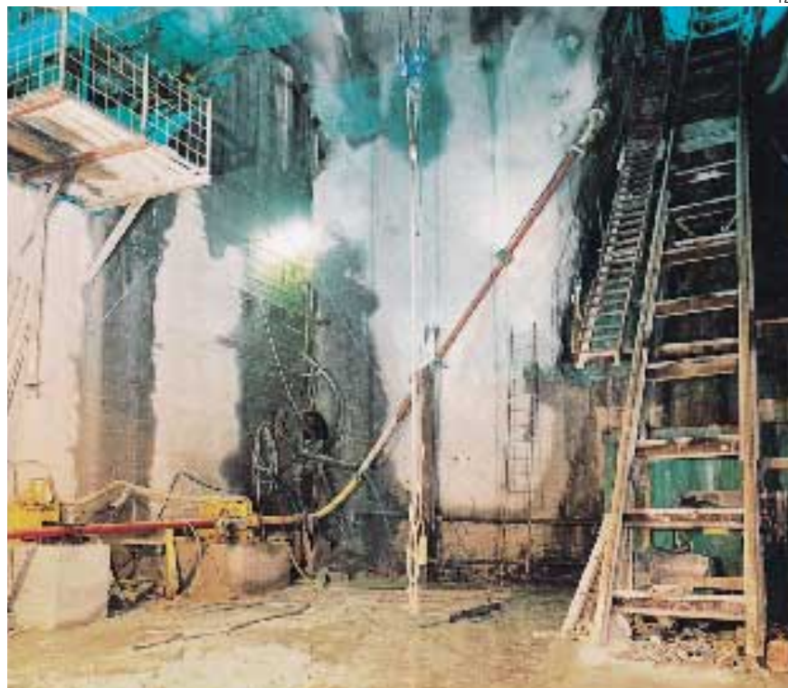
Récord mundial: transporte de hormigón hasta 532 metros de altura a través de una tubería ZX de 100-250 bar.
