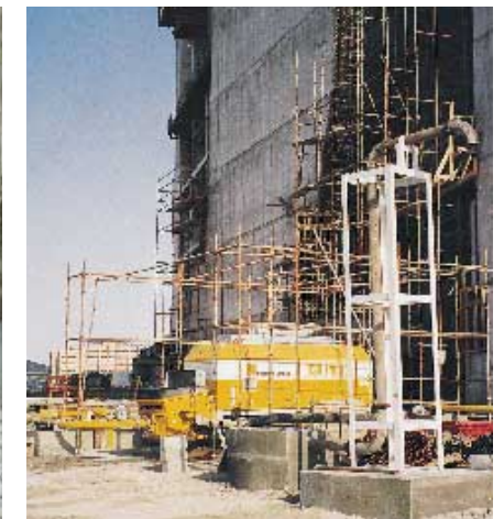
Tubería ZX para 125-200 bar, para transporte en altura con estación de limpieza.
