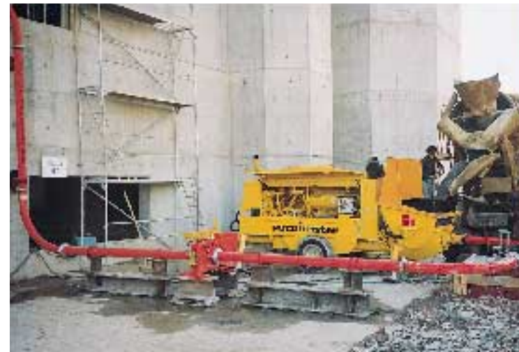
Las tuberías ZX resistentes a altas presiones hasta 250 bar son imprescindibles en la construcción de edificios.
