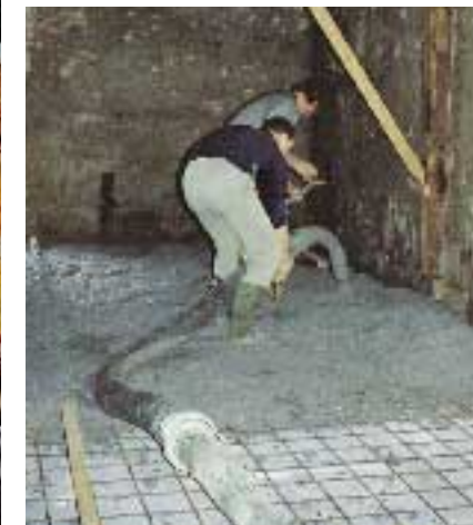
Mangueras PX-Ultraflex®: en lugares de poco espacio o cuando se precisan montajes rápidos.
