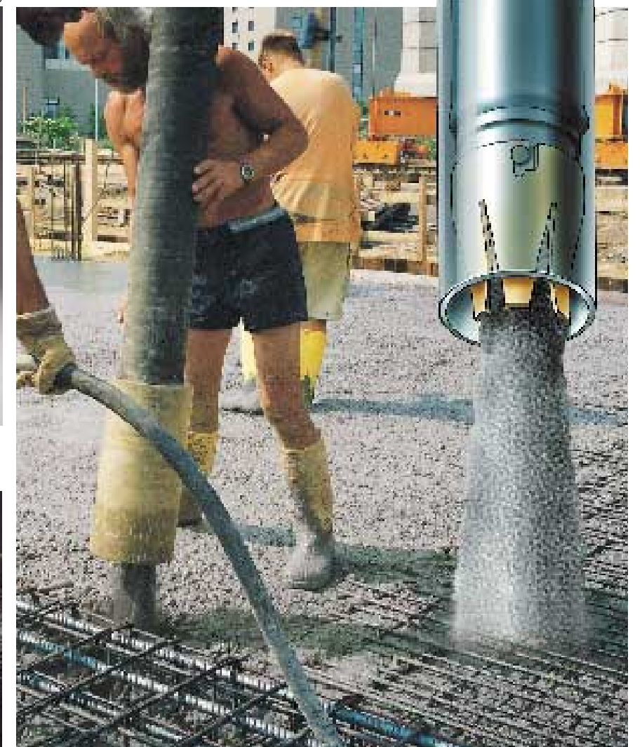
Manguera terminal real. Hormigonado sin salpicaduras gracias a la boquilla ajustable.
