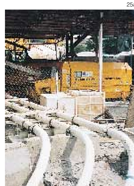
Tuberías ZX con acoplamientos roscados para el transporte en altura y a distancia.
